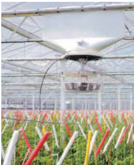
VentilationJet systeem bestaat uit een koker met een inblaas- en een verdeelventilator.
