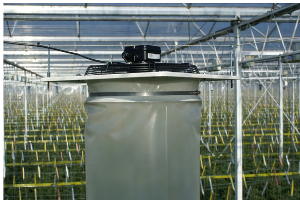
Verti-Fan® ophangen aan een rvs staalkabel
